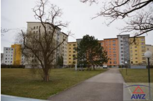
Park - abgeschlossen / Schiebetor
